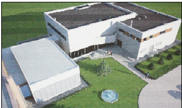
Cum arată Complexul „Sfânta Maria” acum și cum va arăta la finalizarea lucrărilor
