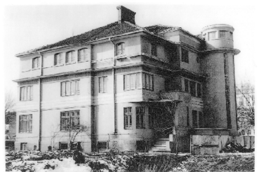
CLĂDIREA SPITALULUI DERMATO-VENERIAN ÎNAINTE DE TRANSLATIE, CONSTRUIT ÎNTRU 1933-1934, AVÂND DEMISOL, PARTER ȘI 2 ETAJE, CU O SUPRAFAȚĂ DE 1428 m 2 , ÎNALȚIME DE 15,0 m ȘI O GRĂBITE DE 30% ÎNCLINATĂ. A FOST TRANSLATĂ PE DISTANȚA DE 68,0 m ȘI ÎN UN UNGHII DE 30°, PE UN PLAN ÎNCLINAT CU PANTA DE 2%.
